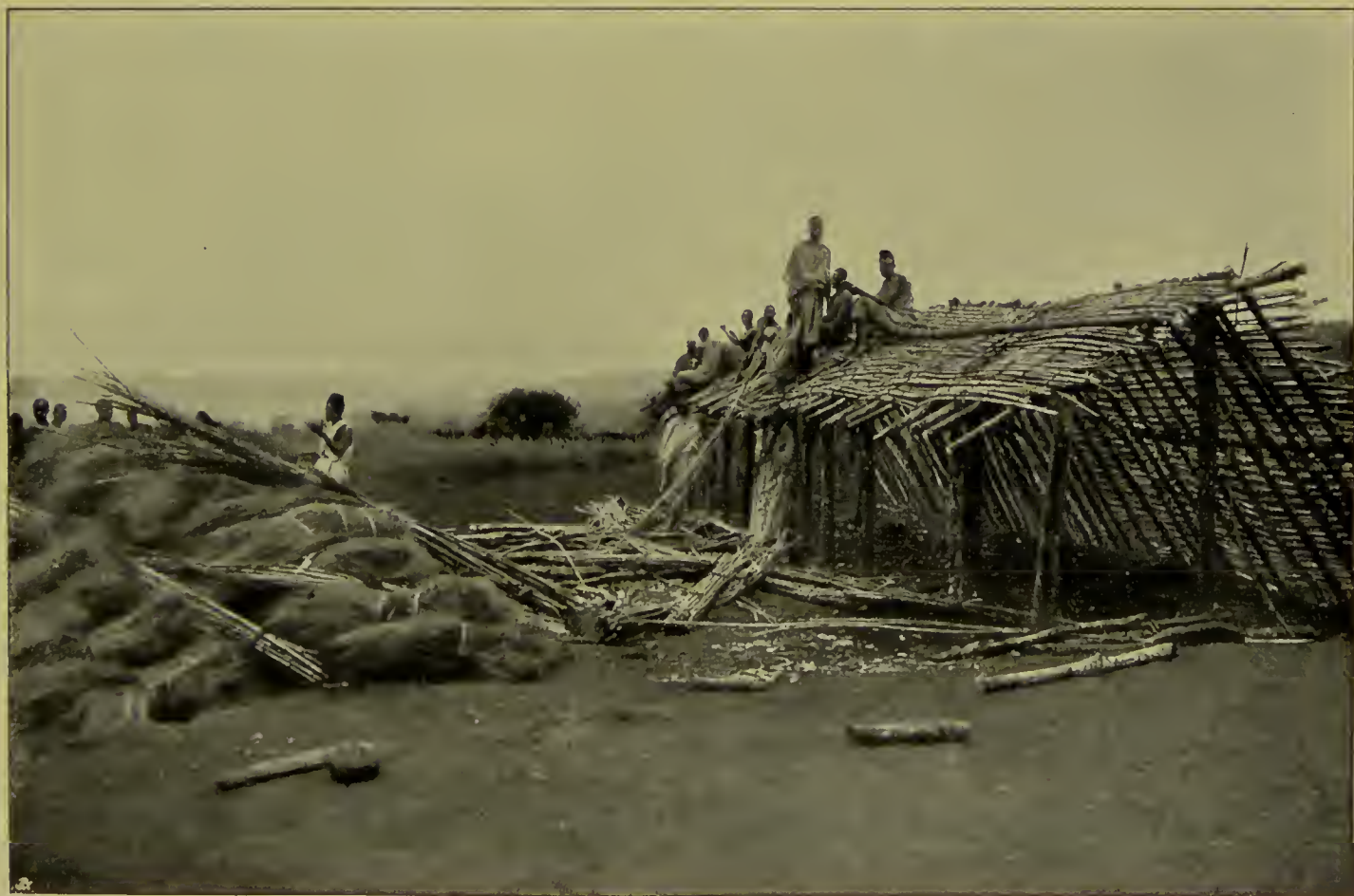
Fig. 78 und 79. Baracken im Bau.
